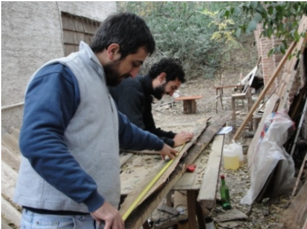
Construcción de las composteras
