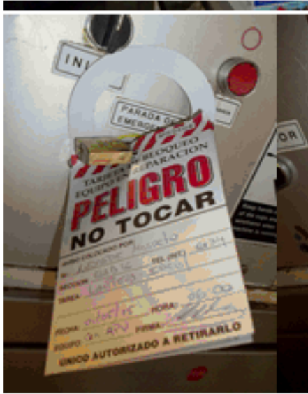
Imagen 30. Equipo bloqueado y etiquetado con tarjeta de consignación
