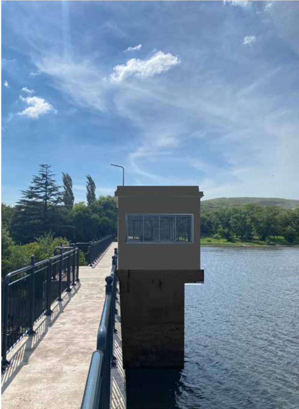
imagen 1. Vista peatonal torre
