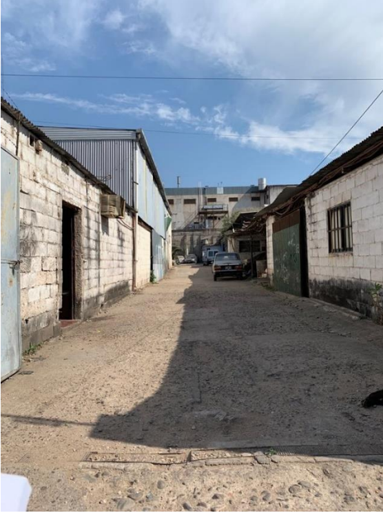
Imagen 3: Calle no asfaltada. Córdoba, Argentina. Septiembre 2019.
