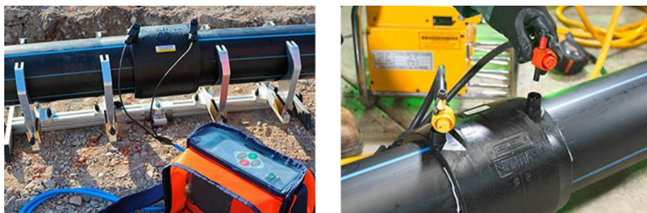
Figura 11. 4 – “Soldadura por electrofusión. Ejecución”
