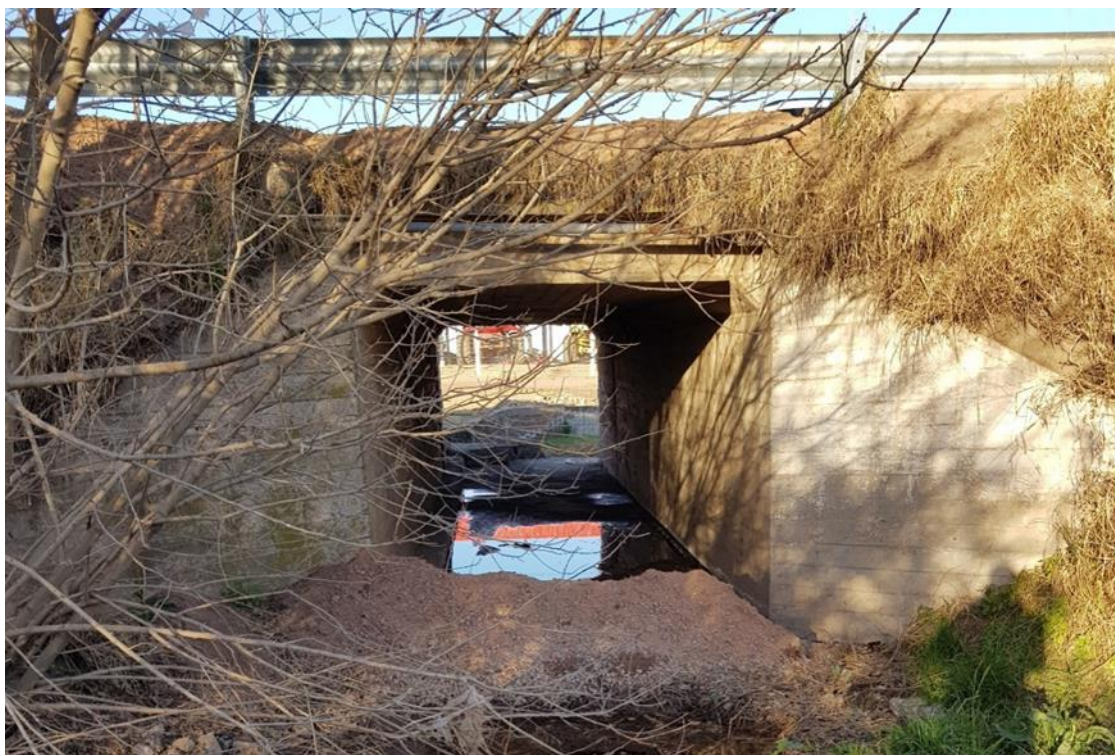
Figura 10. 6 – “Obra desagüe bajo nivel RN9”
