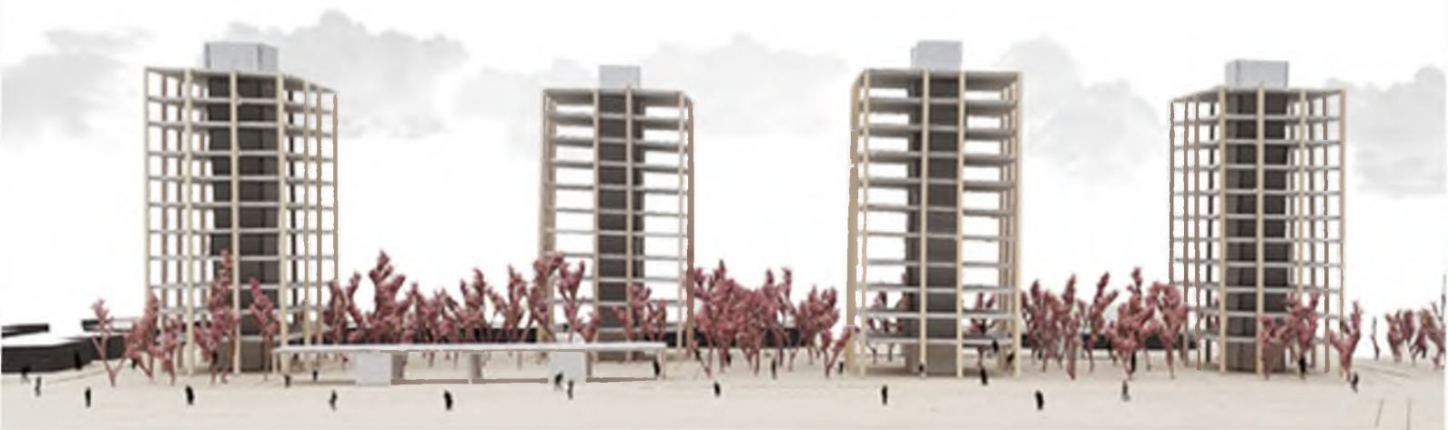
Estructura perimetral con columnas de hormigón visto
