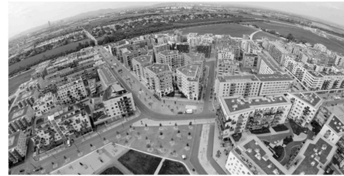
Aspern , la ciudad inteligente sin coches y laboratorio urbano de estilo de vida sostenible a 14 kilómetros de Viena: enfoque integral que incluye sistemas de movilidad sostenibles, utilización eficiente de recursos energéticos renovables, edificios sostenibles, agricultura urbana, usos residenciales y de negocios mixtos y bienestar social en forma de servicios.
