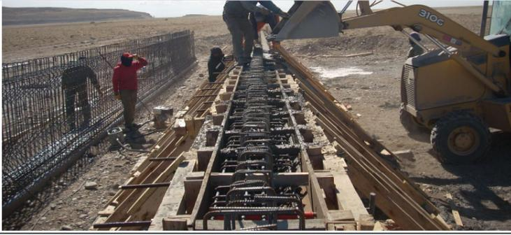
Armado y Hormigonado de Vigas Postensadas
