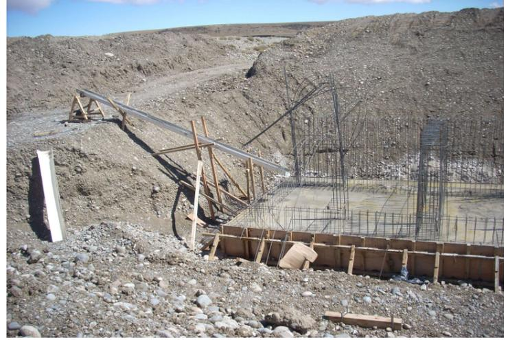
Curado del Hormigonado de la primea etapa de los Estribos del puente Los Paisanos
