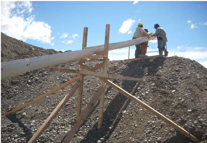
Armado de Canaletas para Hormigonado de Estribos
