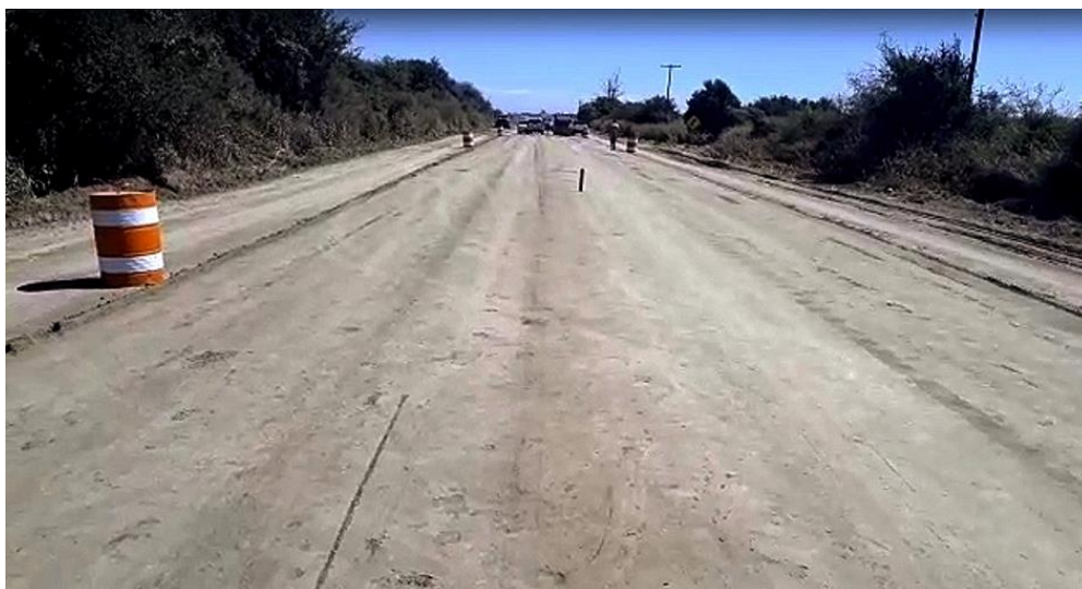
Figura 217: Tramo ya compactado, listo para ser imprimado. 219
