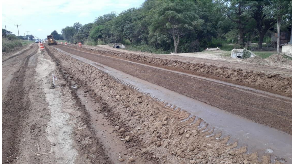
Figura 222: Nivelación tramo 2. 224
