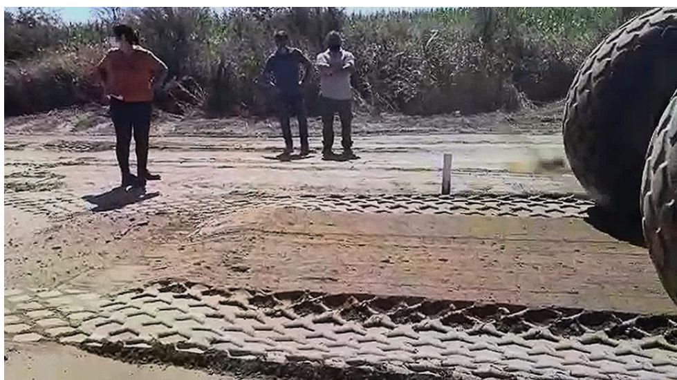
Figura 232: suelo y cemento ya mezclado. 234
