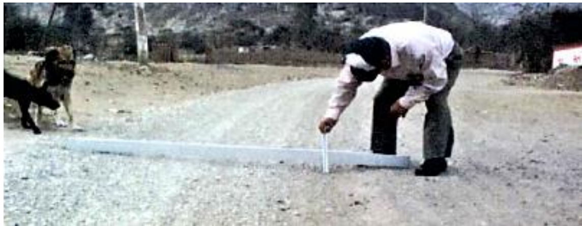
Figura 174: Ahuellamiento de mediana severidad. 179
