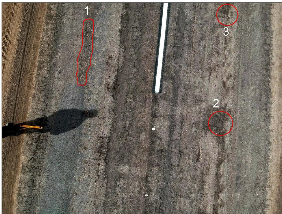
Figura 242: Baches. Tramo1 - imagen 0894.
