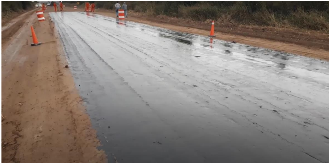
Figura 219: Imprimación E.I.A. en tramo 1. 221
