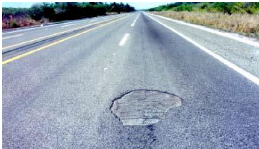
Figura 78: Desintegración por peladura. 83
