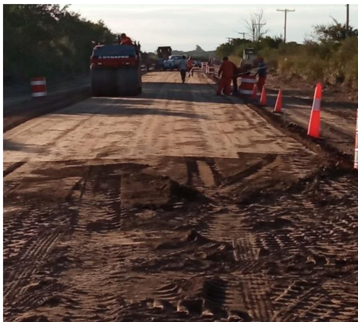
Figura 216: Proceso de compactación en tramo1. 218
