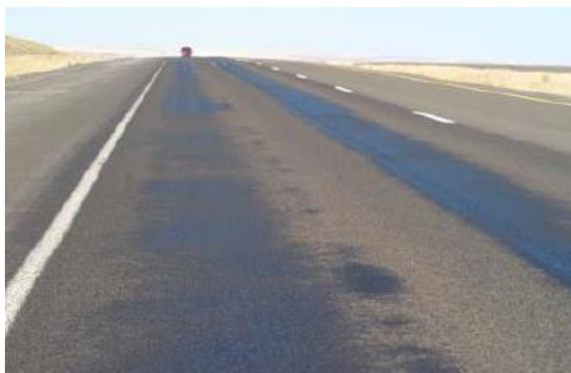
Figura 96: Exudación del asfalto con mediana severidad. 101
