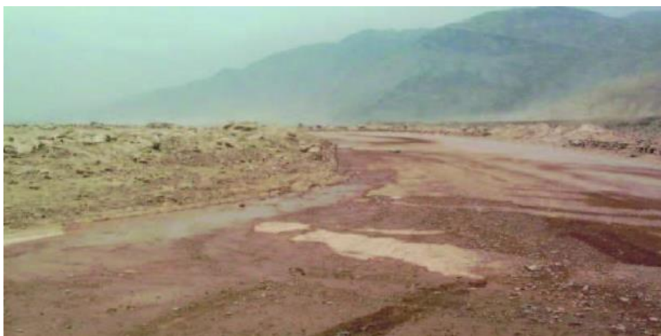
Figura 169: Bache de severidad media. 174
