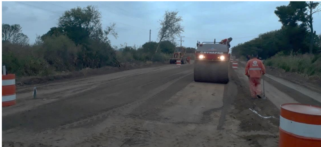
Figura 226: Compactación de material granular. 228
