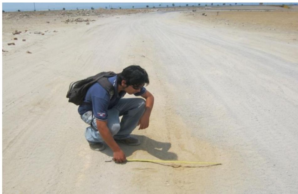
Figura 168: Bache de baja severidad. 173
