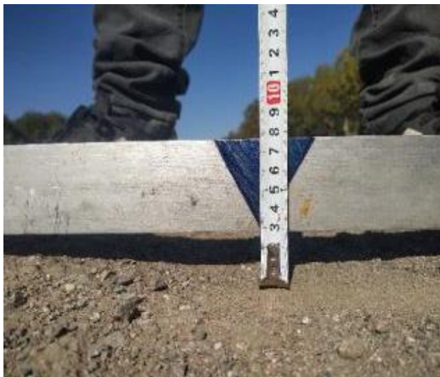
Figura 236: Profundidad. Tramo 1 – imagen 1. 236
