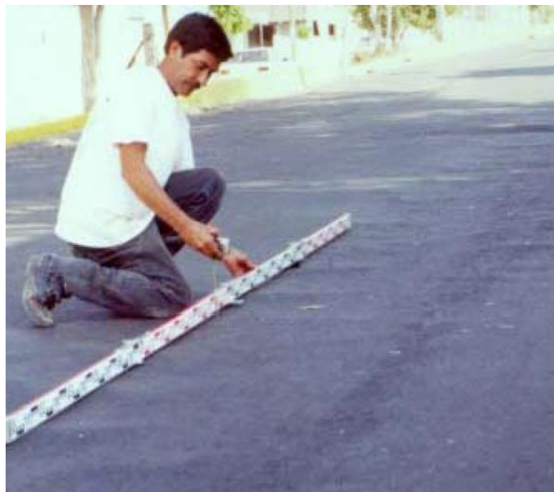
Figura 40: Corrugación con nivel medio de severidad. 45
