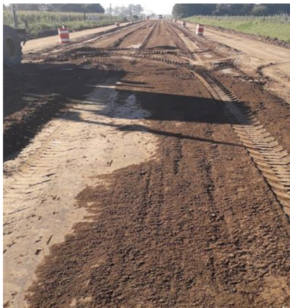
Figura 229: Premezclado de aditivo polimérico con material granular 0 -14. 231
