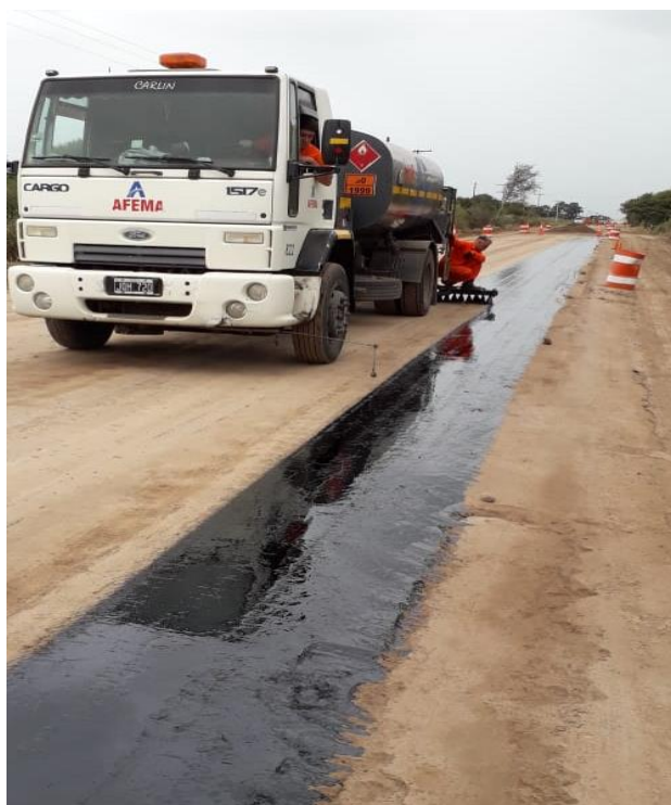
Figura 218: Riego de imprimación con E.A.I. en tramo 1. 220
