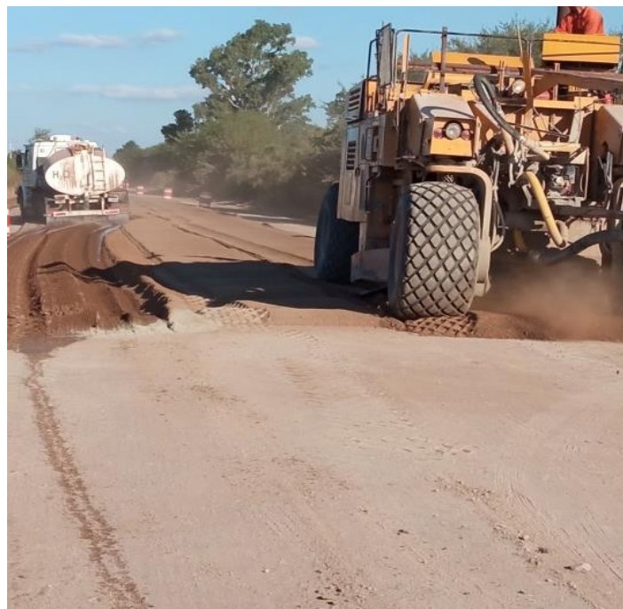
Figura 214: Premezclado de agua + estabilizador iónico con reclamadora. 216
