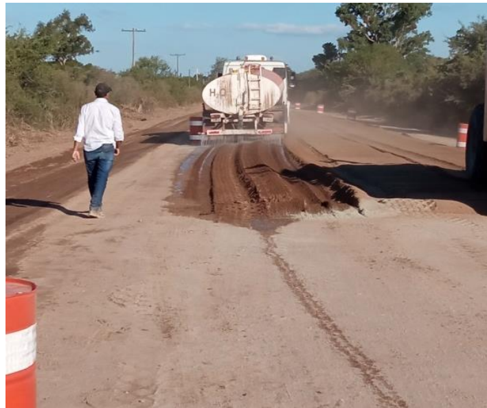
Figura 213: Riego de estabilizador iónico. 215
