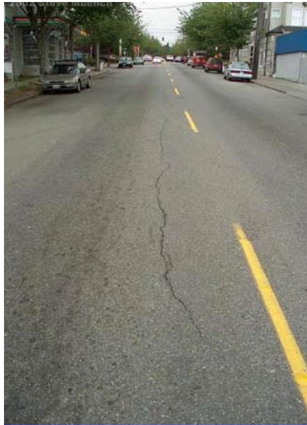
Figura 50: Fisura longitudinal con bajo nivel de severidad. 55
