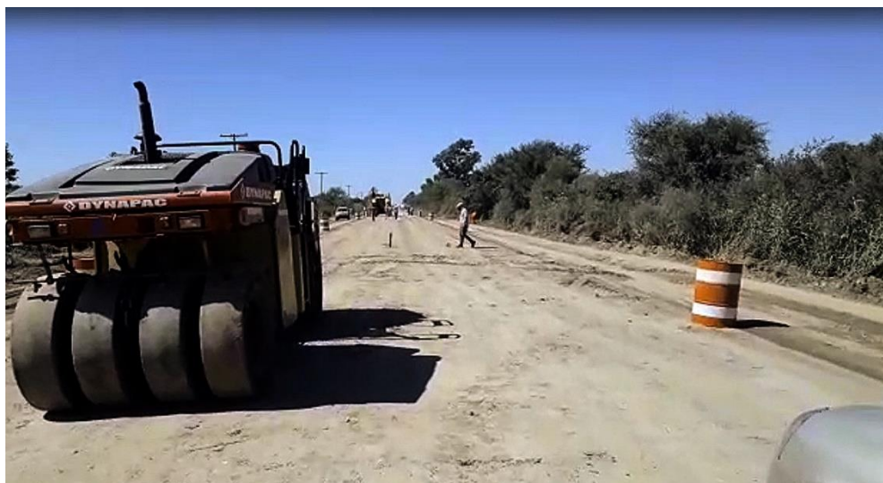
Figura 233: Compactación con rodillo neumático. 235
