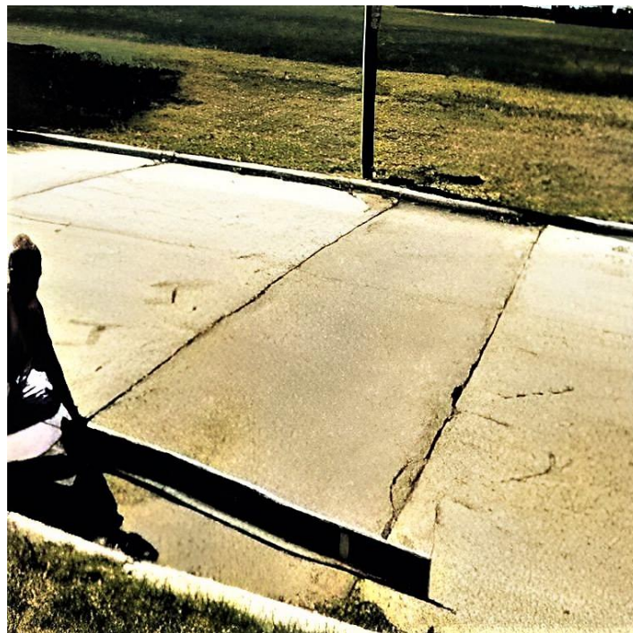
Figura 103: Bacheo de severidad media. 108
