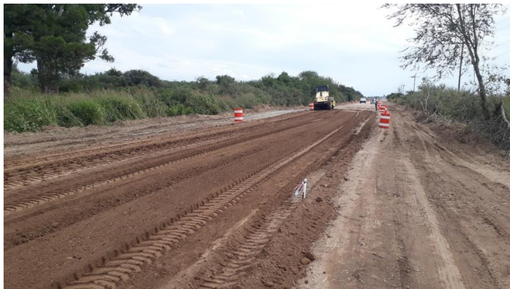
Figura 223: Compactación tramo 2. 225
