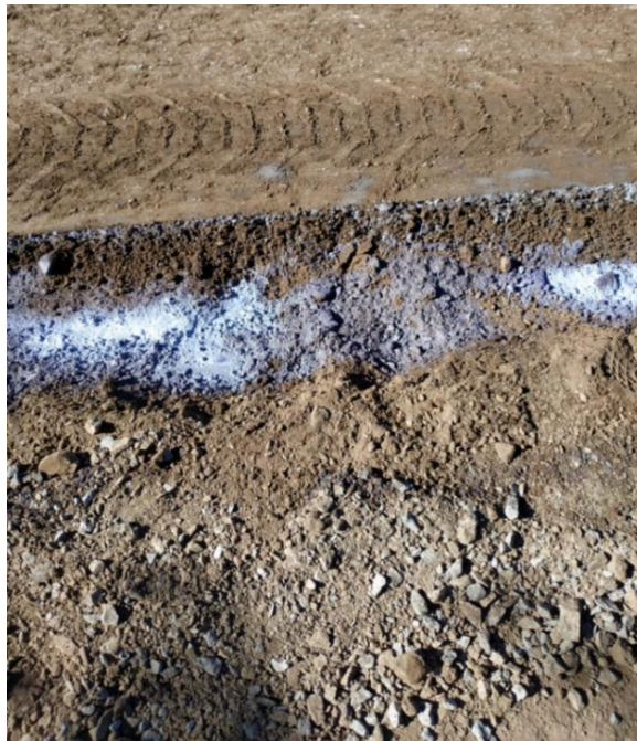
Figura 228: Aditivo polimérico diluido en agua, tramo 2. 230
