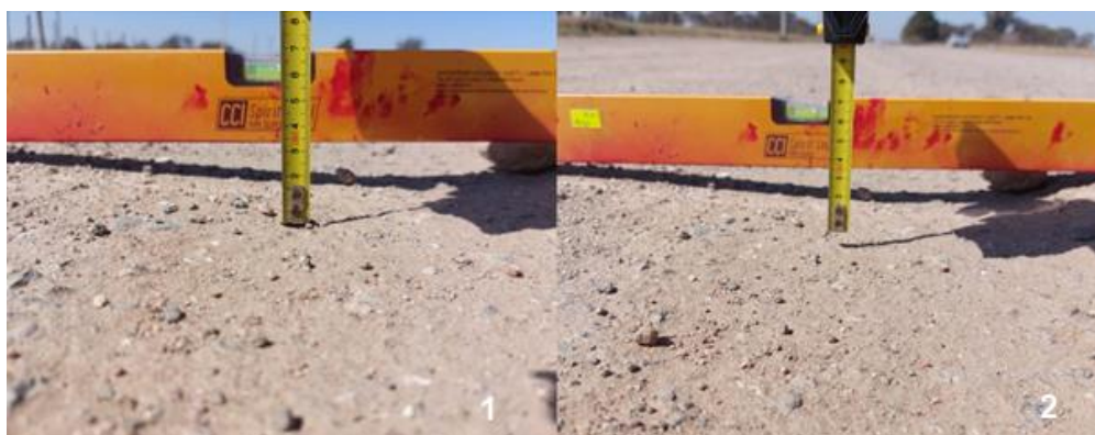
Figura 271: Profundidad. Tramo 2 - último relevamiento.
