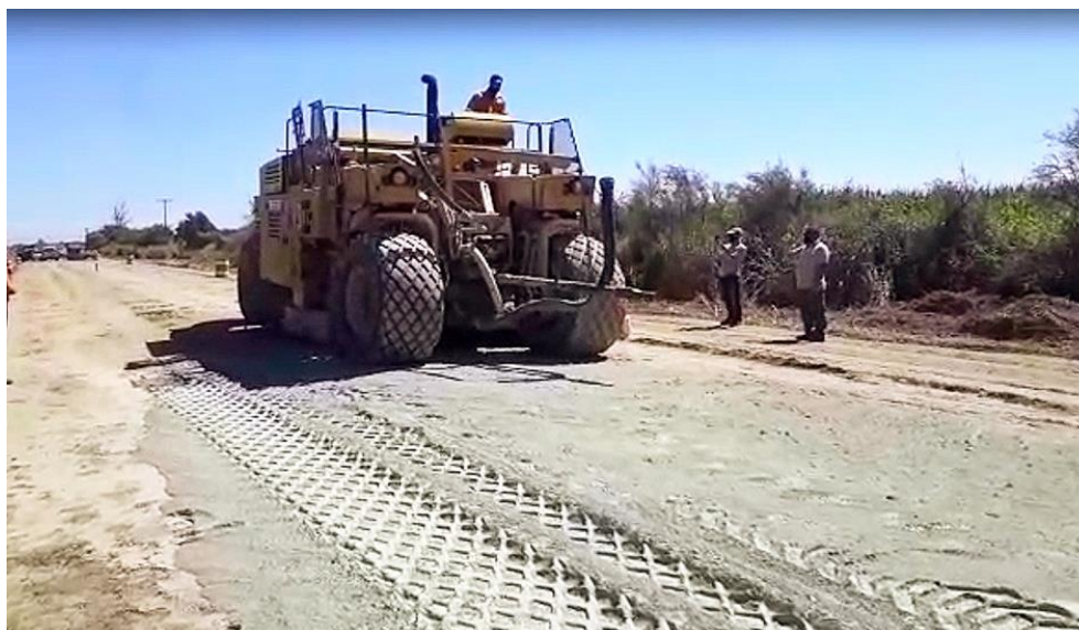
Figura 231: Mezclado del suelo y cemento con reclamadora. 233
