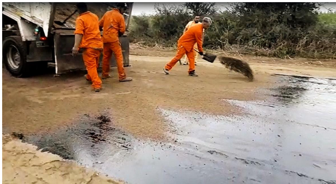
Figura 220: Granzeado de arena gruesa en tramo 1. 222
