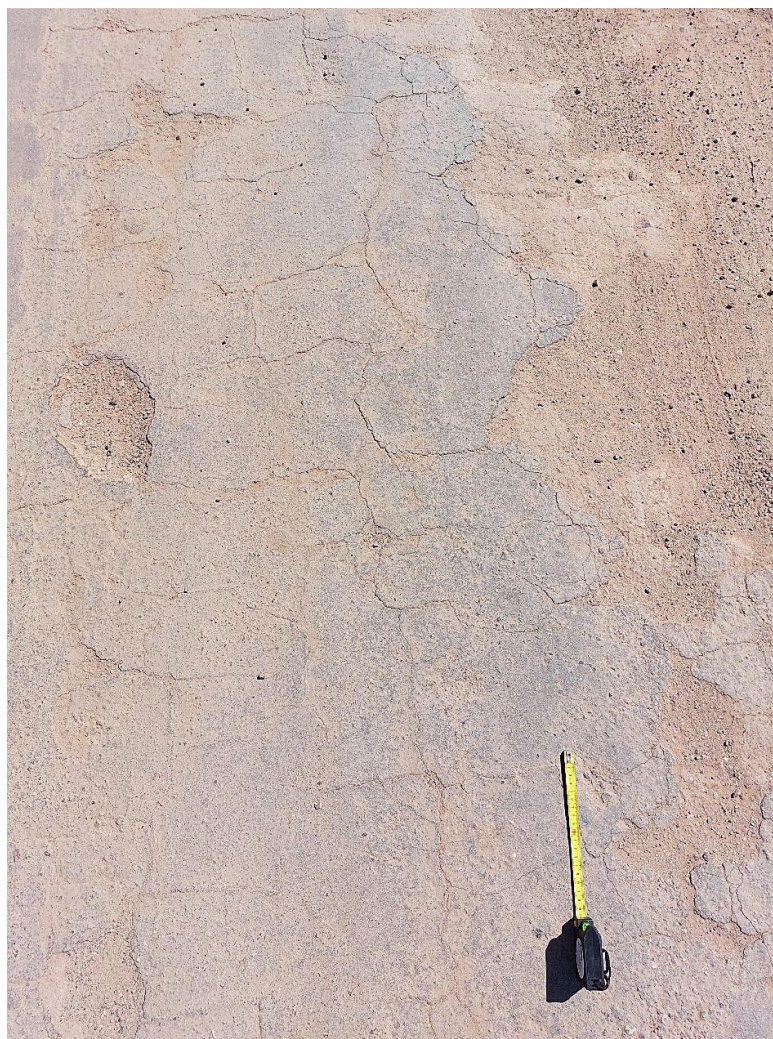
Figura 264: Detalle piel de cocodrilo. Tramo 1.
