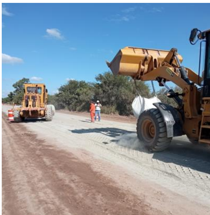
Figura 210: Distribución de cemento en tramo 1. 212
