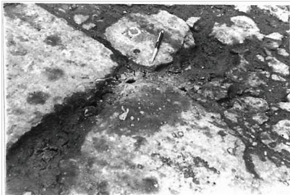
Figura 132: Bombeo de alta severidad. 137
