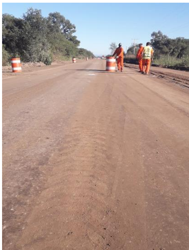
Figura 230: Perfilado final de aditivo polimérico en tramo 2. 232
