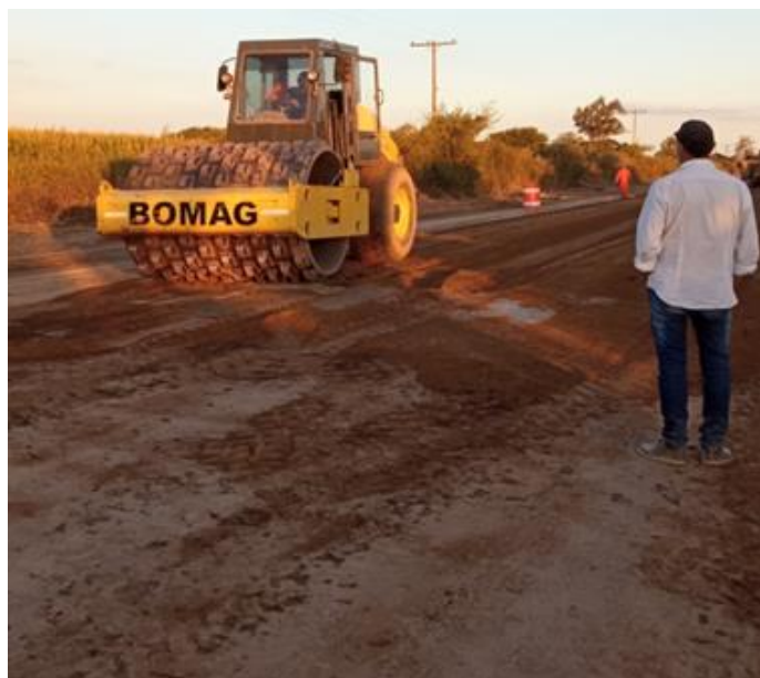
Figura 215: Compactación inicial en tramo 1. 217
