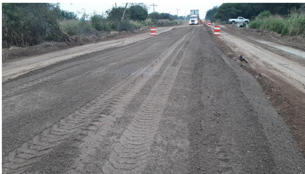
Figura 224: Extendido del material granular 0-14 en tramo 2. 226
