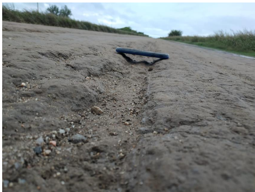
Figura 293: Tramo estabilizado con ligante hidráulico de uso vial.
