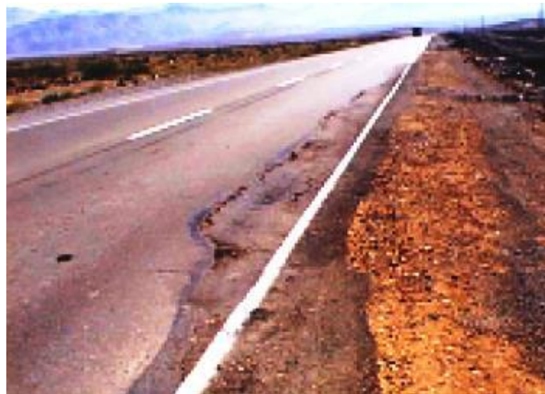
Figura 91: Desintegración de borde con alta severidad. 96
