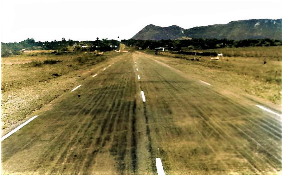
Figura 82: Estrías longitudinales de severidad media. 87
