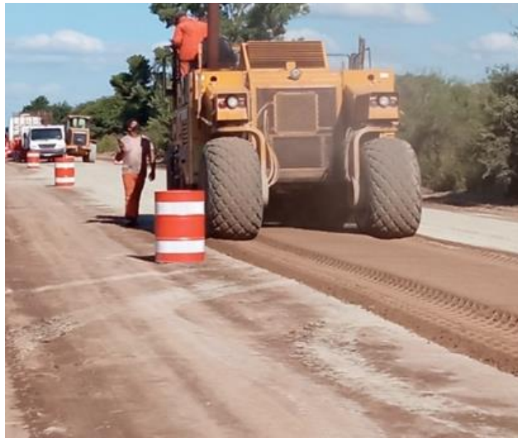
Figura 211: Premezclado de suelo-cemento en tramo1. 213
