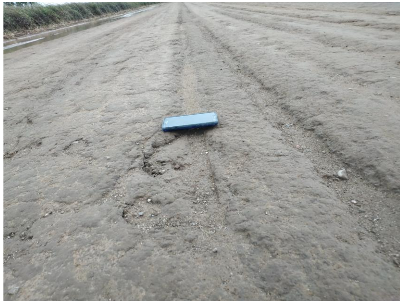
Figura 294: Tramo estabilizado con ligante hidráulico de uso vial
