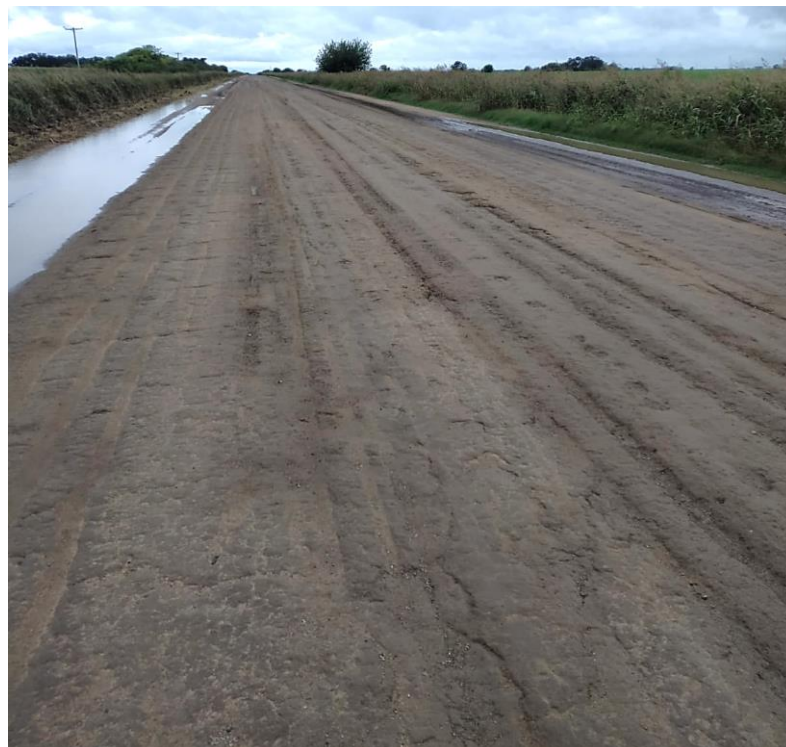
Figura 295: Tramo estabilizado con ligante hidráulico de uso vial.
