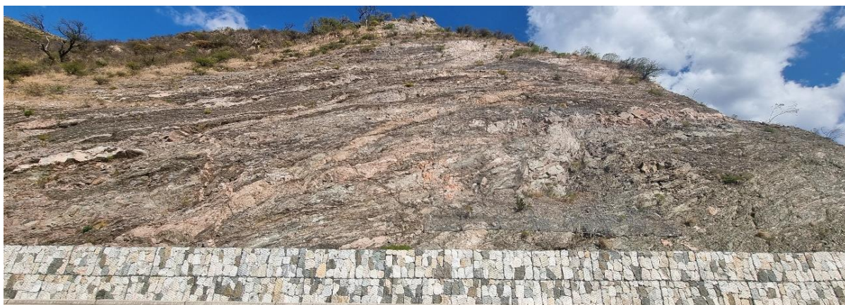
Medidas de remediación existentes: enmallado simple con anclajes y muro de gaviones.
