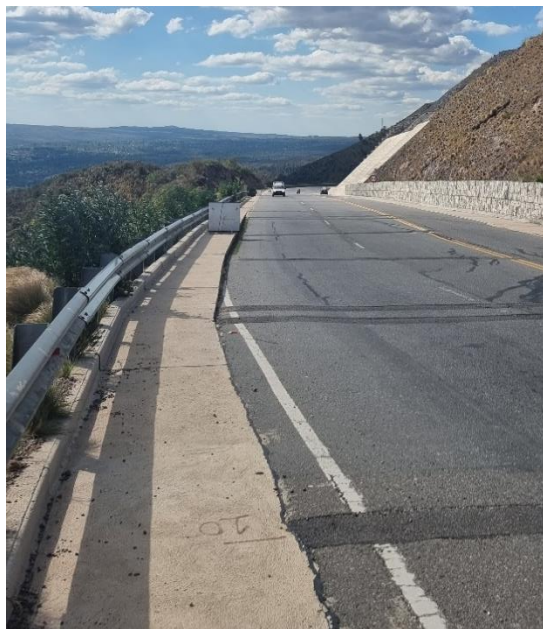
Figura 83. Remediación con vigas y pilotes.
