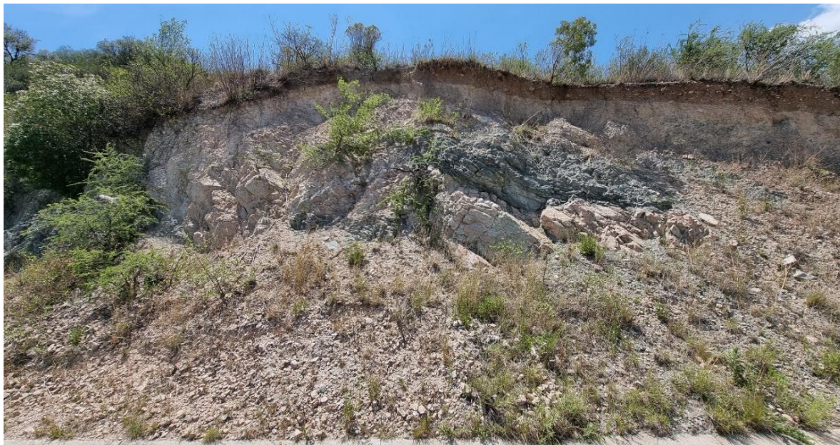
Figura 61. Vista del talud T1. Fuente: Autor.
