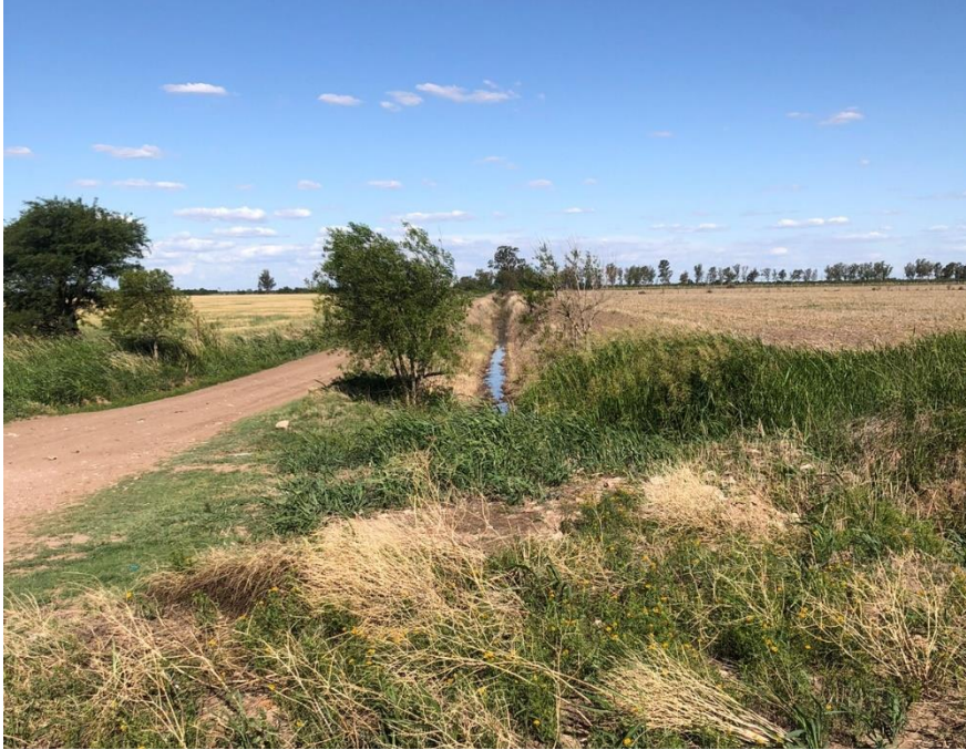
Ilustración 49 - Cuneta de desagüe 1.
