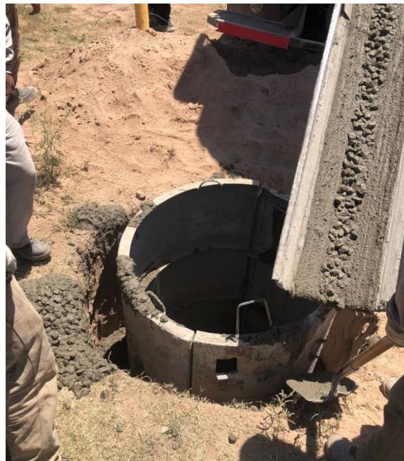
Ilustración 15 - Hormigonado de Boca de Registro.
