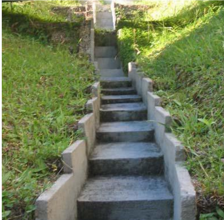
Ilustración 89 - Disipador de energía escalonado.
