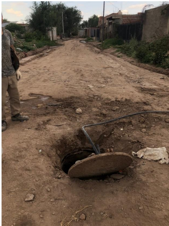
Ilustración 18 - Llenado de tubería para prueba hidráulica.
