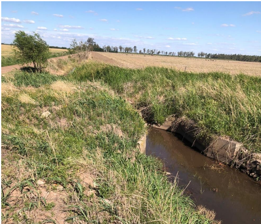
Ilustración 50 - Cuneta de desagüe 2.
