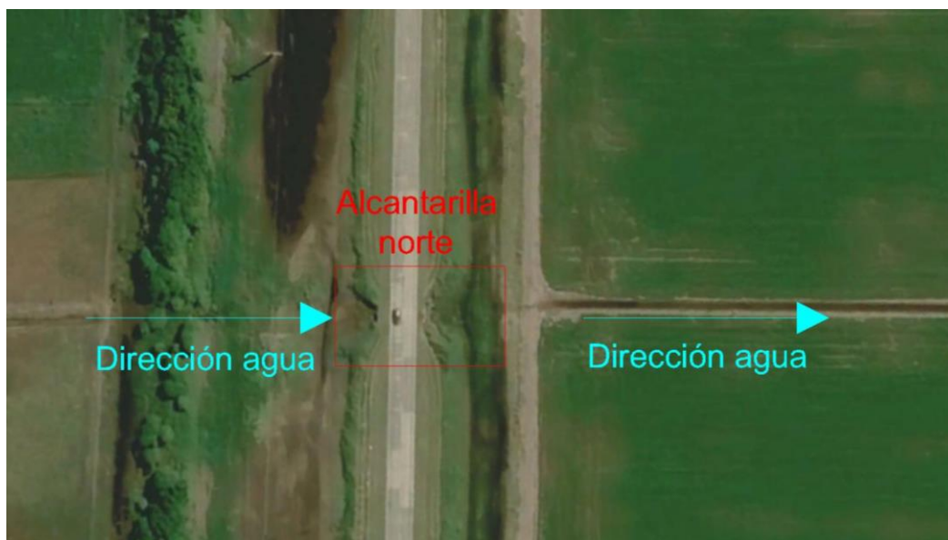
Ilustración 40 - Alcantarilla Norte – Google Earth.
