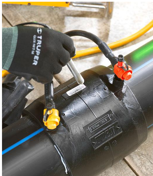
Ilustración 92 - Unión de caños por termofusión.
