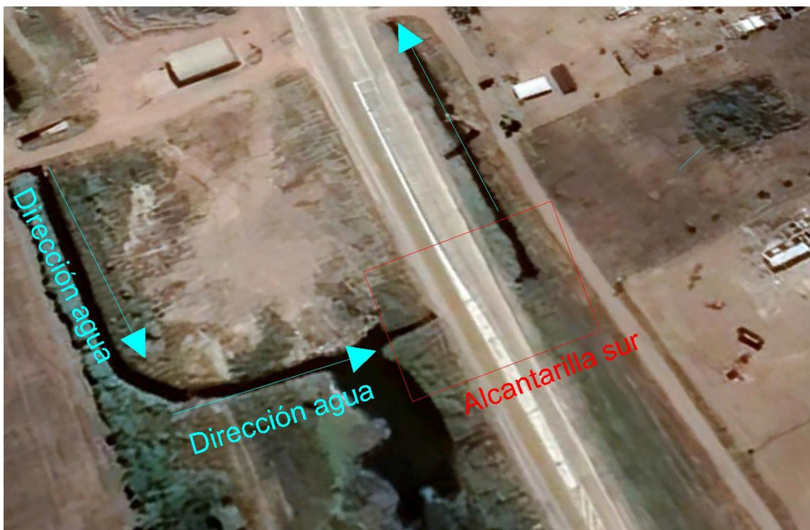
Ilustración 44 - Alcantarilla Sur 2 – Google Earth.
