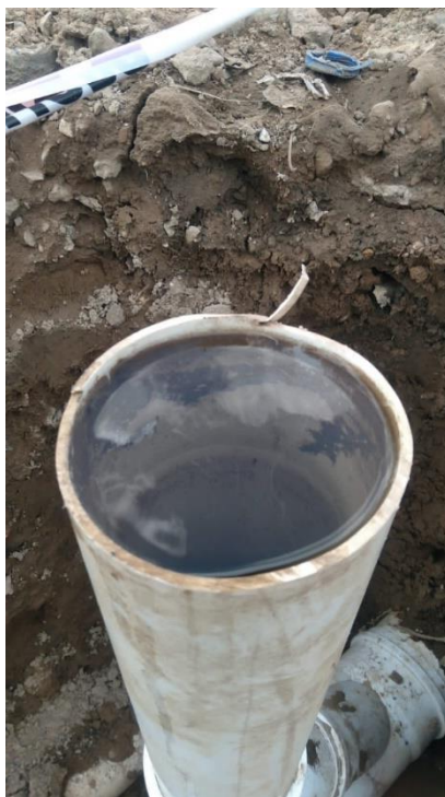
Ilustración 16 - Prueba Hidráulica Cloacal 1.
