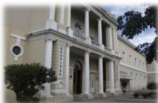
Fachada de la ex Casa Cuna sobre Boulevard Castro Barros. Fuente propia.
