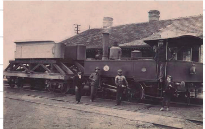
Estación del Ferrocarril Oliva, Maquinaria de alineación de vías ferreas. 1910.
