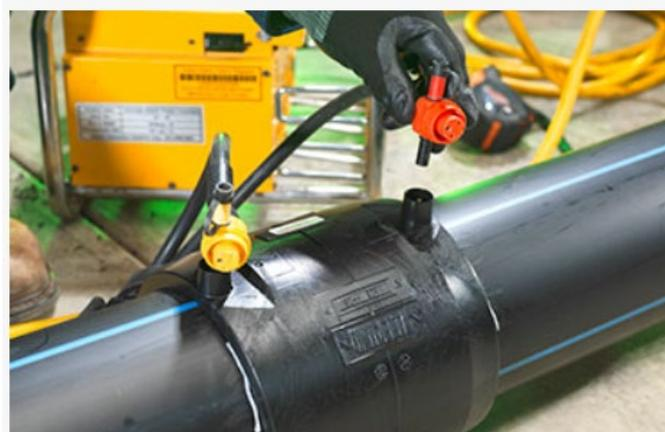
*Figura N° 13-5 Soldadura por electrofusión. Ejecución*
