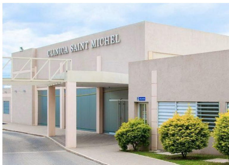
Fachada de la clínica Saint Michel
