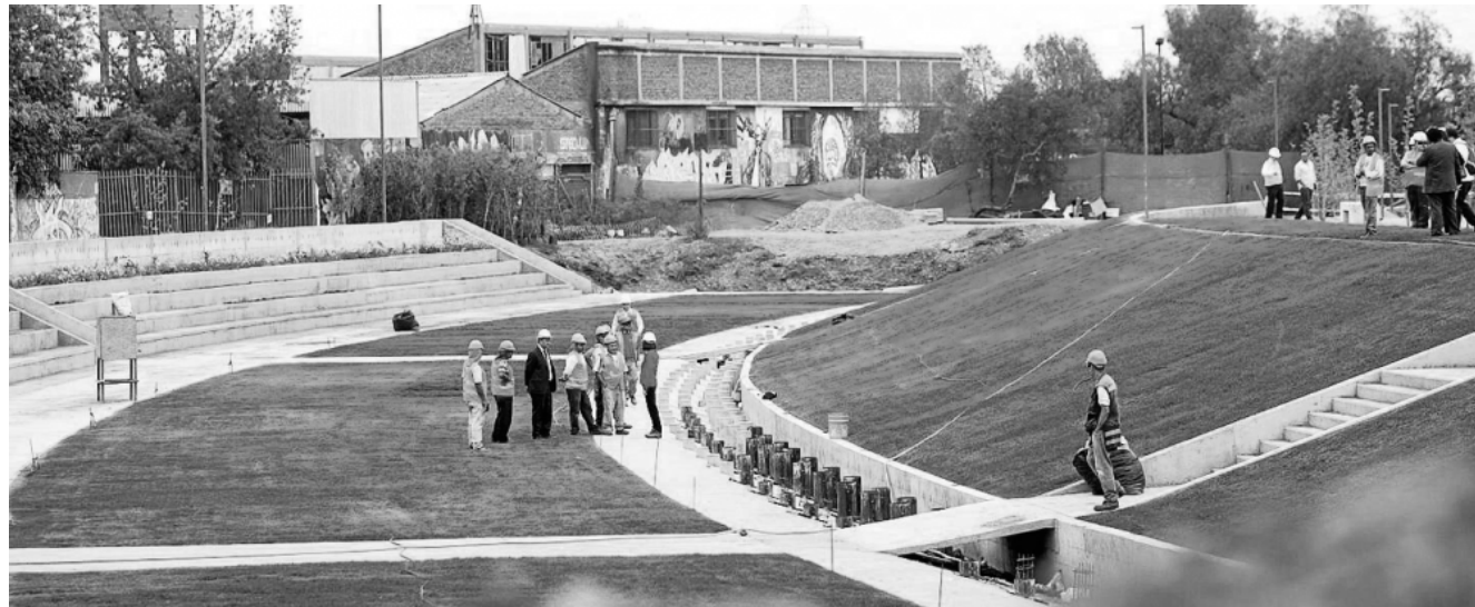
(7) Parque inundable a punto de finalizar el primer tramo
