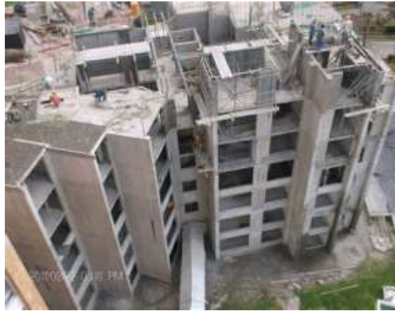
B. Sistema de muros de carga.
