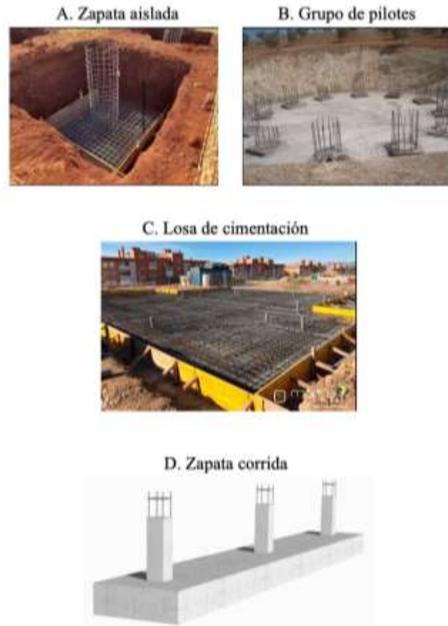
Figura 6. Tipos de cimentación en el sistema constructivo tradicional.
