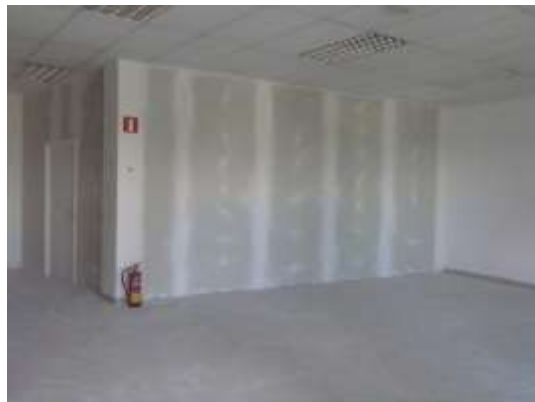
c) Tabiquería en paneles de yeso-cartón.
