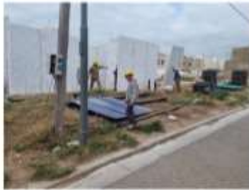
C. Montaje de los paneles
