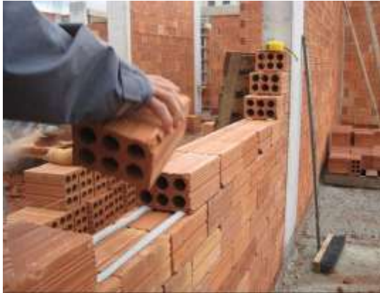
a) Tabiquería en arcilla.
