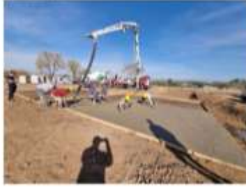
A. Proceso de ejecución de una platea fundación
