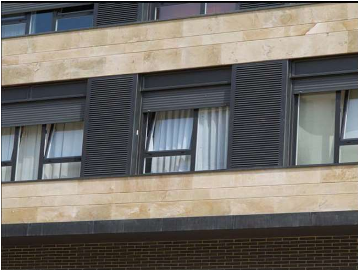
Figura 10. Carpintería en aluminio aplicada en ventanas.
