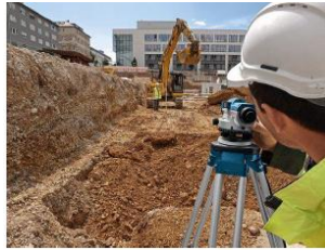
Figura 3.1.5.1-2 - Replanteo con nivel óptico. (Chaer, 2020)
