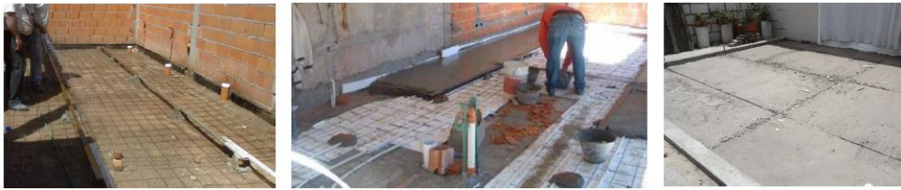
Figura 3.1.8.4-3 – Fotografías de obra. (edumferreyra, 2013)
