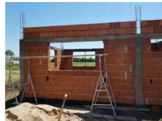
Figura 3.1.5.1-3 - Fotografía ilustrativa de encadenado vertical. (Río cuarto, 2024)
