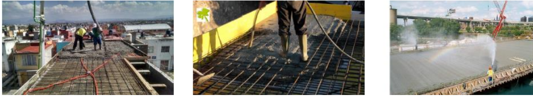
Figura 3.1.6.1-1 - Colocado curado y vibrado. (MRM Contrucción, 2018)
