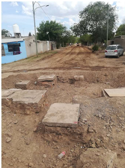
FOTOGRAFÍA N° 2: Ejecución del badén (año 2019)
