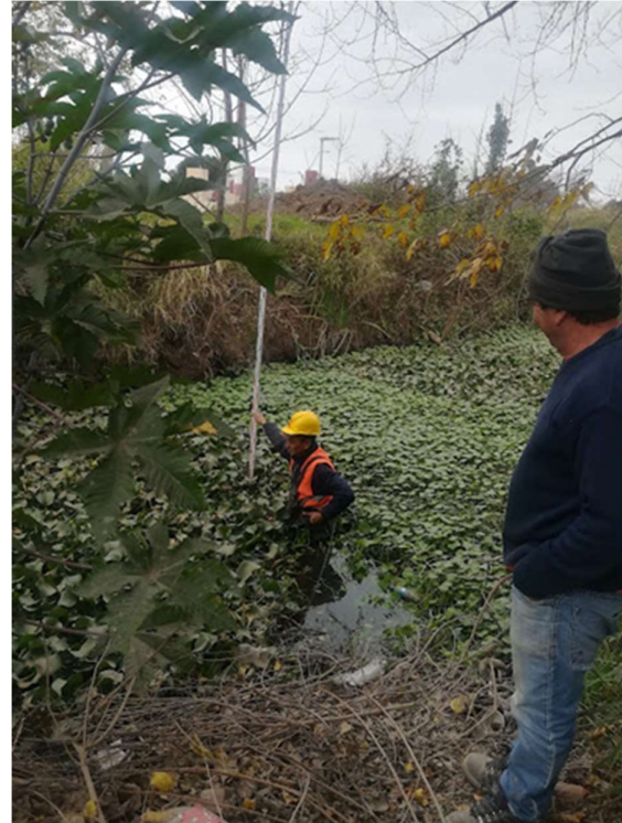
FOTOGRAFÍA N° 11: Operario sosteniendo la mira para la nivelación
