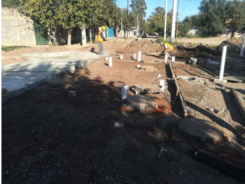
FOTOGRAFÍA N° 4: Ejecución del badén (año 2019)
