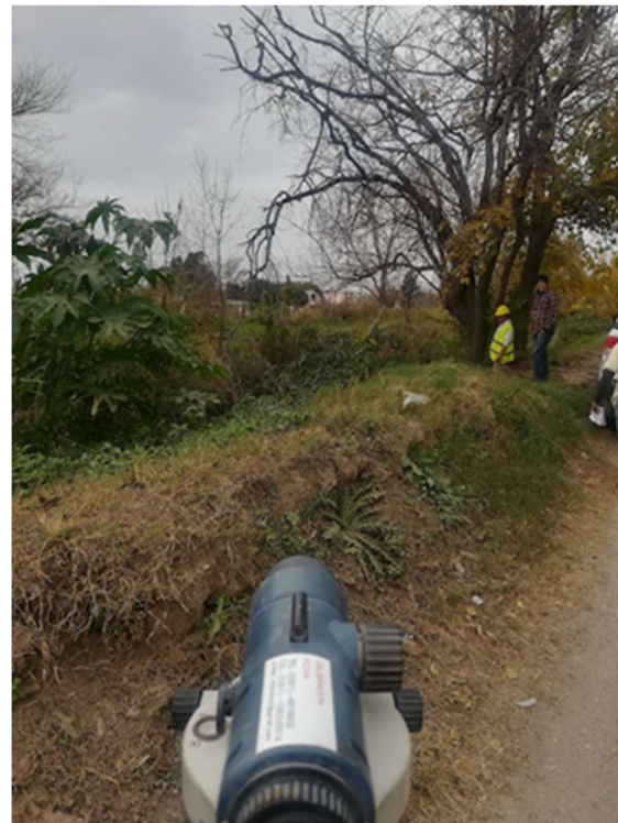
FOTOGRAFÍA N° 9: Posicionamiento del instrumental de medición
