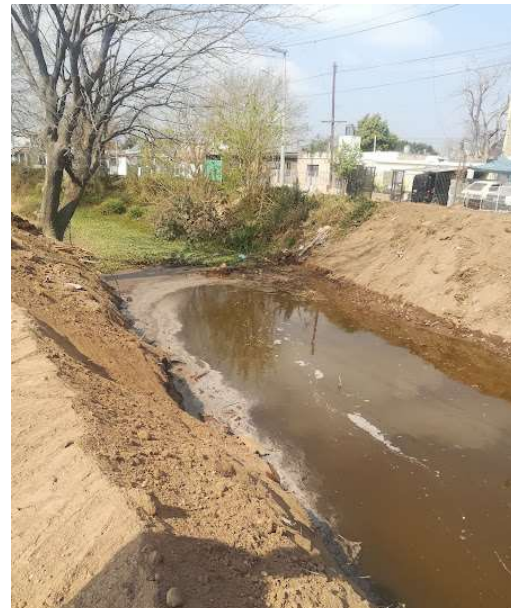
FOTOGRAFÍA N° 17: Canal restituído a su condición anterior
