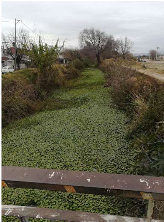
FOTOGRAFÍA N° 8: Estado del canal antes de la intervención
