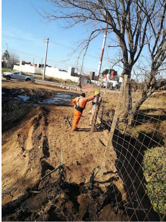
FOTOGRAFÍA N° 12: Cerco de protección en la zona del cruce
