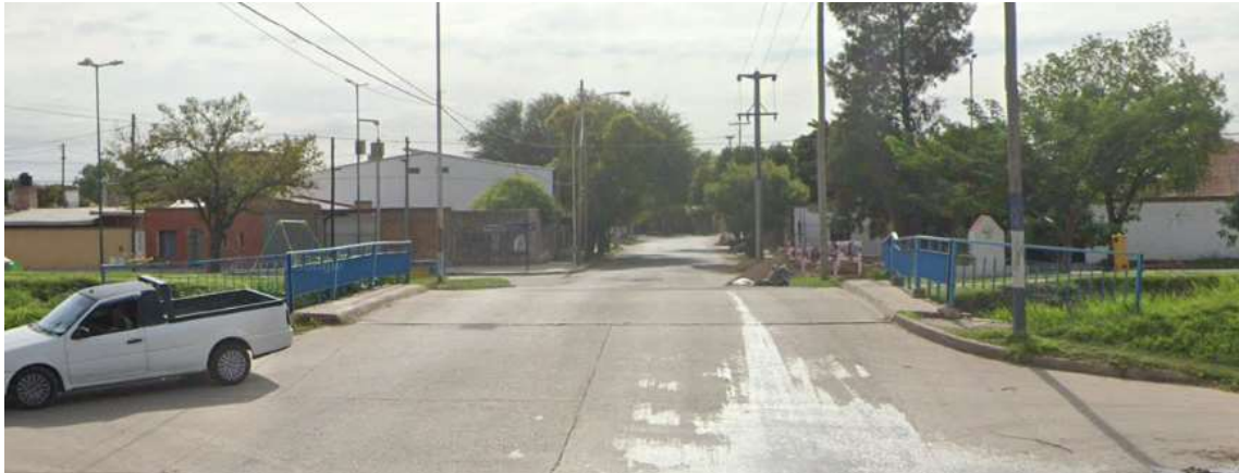
FOTOGRAFÍA N° 6: puente de calle José Iseas sobre el canal Maestro Sur
