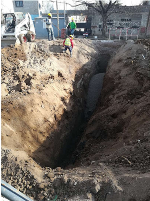
FOTOGRAFÍA N° 15: Cañería colocada y tapada en medio cruce
