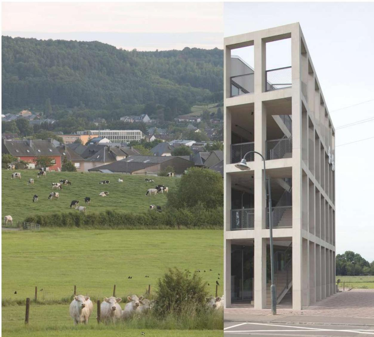
El proyecto se distingue por su fachada regular en hormigón visto, resultado lógico de un análisis detallado de usos, funciones y ergonomía. La cuadrícula racional resultante permite una flexibilidad en la distribución interior y un considerable ahorro de espacio, dado que la fachada constituye el principal elemento estructural.
