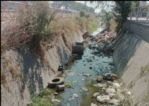
Canal Maestro Sur.
