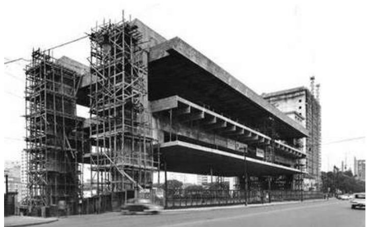
Construcción segundo piso con tensores - Lina Bo Bardi
