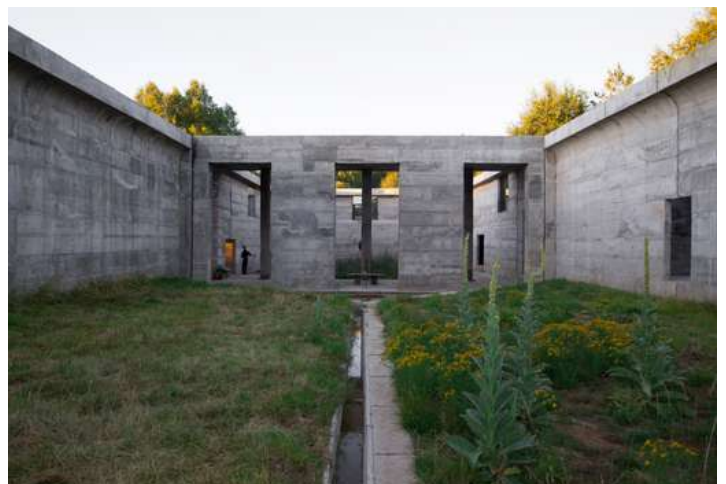
Construcción segundo piso con tensores - Lina Bo Bardi
