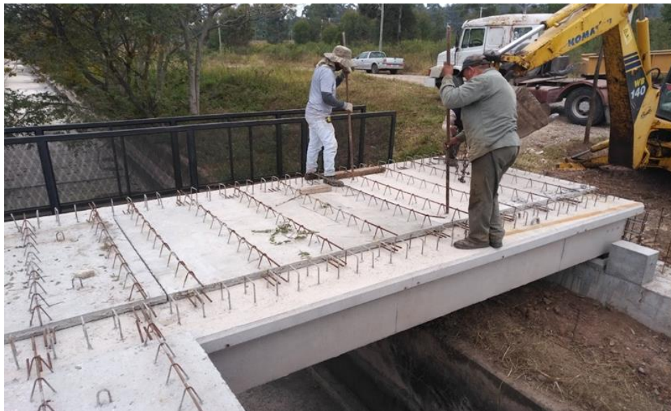
Figura 23 -Colocación de las prelosas de H^{\circ}A^{\circ}
