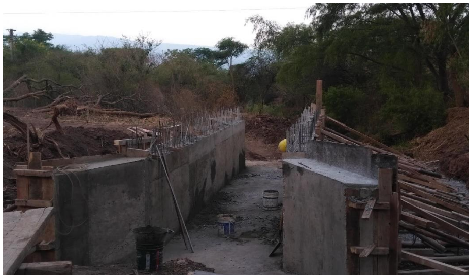
Figura 12 -Alcantarilla en construcción
