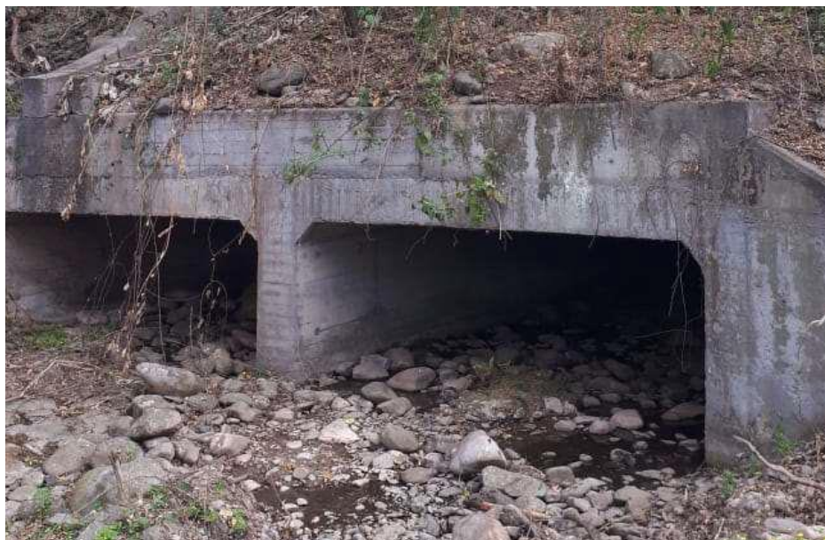
Figura 11 -No evidencian roturas estructurales
