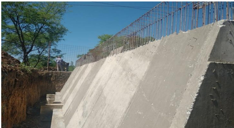
Figura 20 -Desencofrado del estribo
