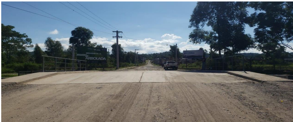
Figura 27 -Losa de aproximación, 2021
