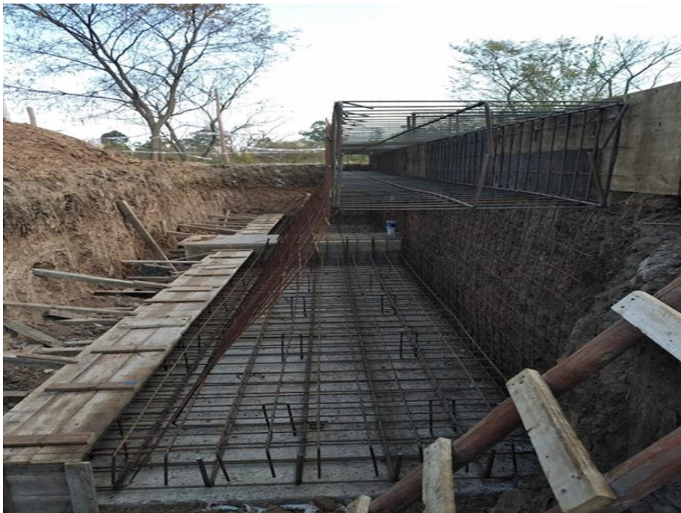
Figura 19 -Armado del estribo
