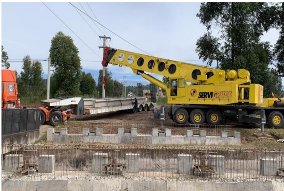
Figura 21 -Montaje de las vigas prefabricadas
