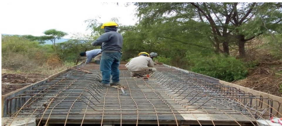
Figura 13 -Armado losa alcantarilla
