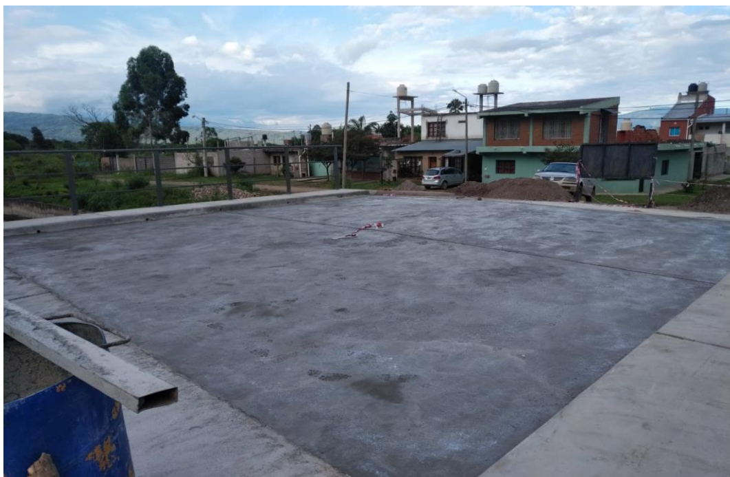
Figura 26 -Curado mediante riego controlado
