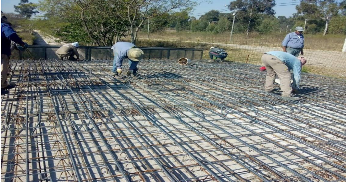
Figura 24 -Armado del tablero
