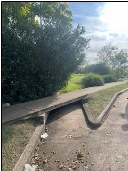
Figura 39 - Obra de ingreso 1 de laguna de retención 4
