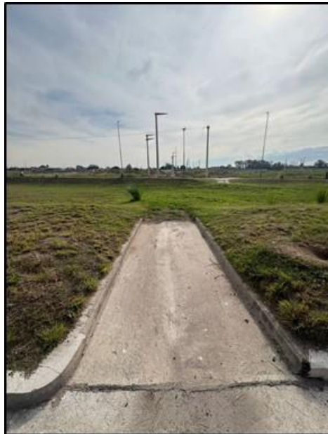
Figura 55 - Obra de ingreso 1 de laguna de retención 9
