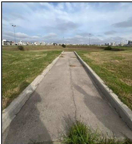
Figura 36 - Obra de egreso (vertedero) de laguna de retención 3
