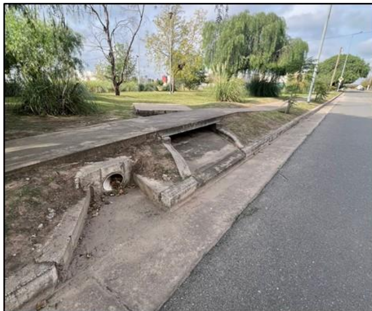
Figura 41 - Obra de egreso de laguna de retención 4
