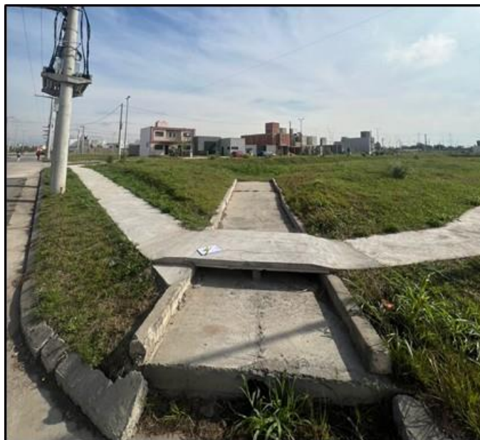
Figura 53 - Obra de egreso de laguna de retención 8
