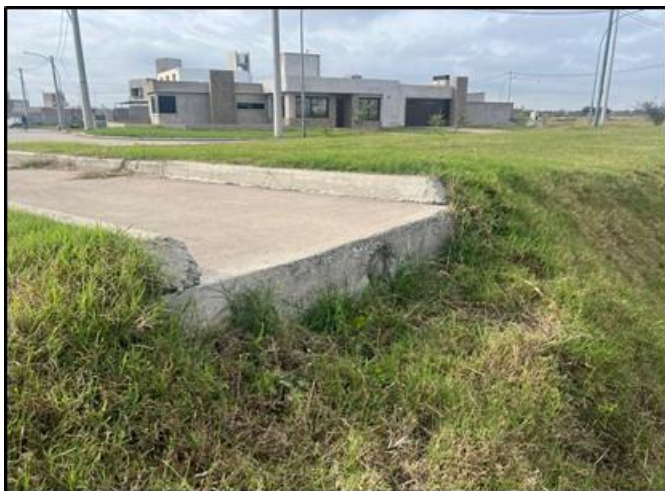
Figura 37 - Obra de egreso (orificio) de laguna de retención 3
