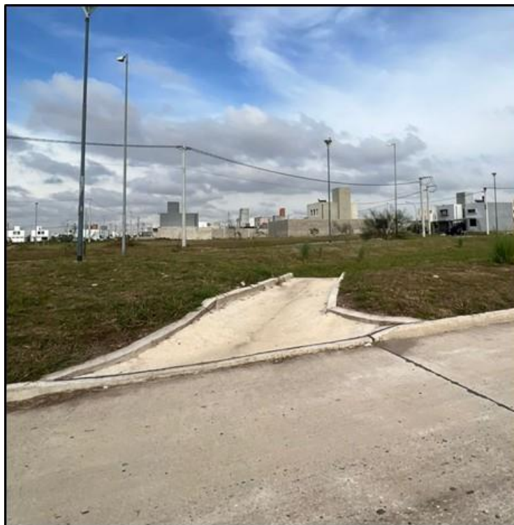
Figura 57 - Obra de egreso de laguna de retención 9
