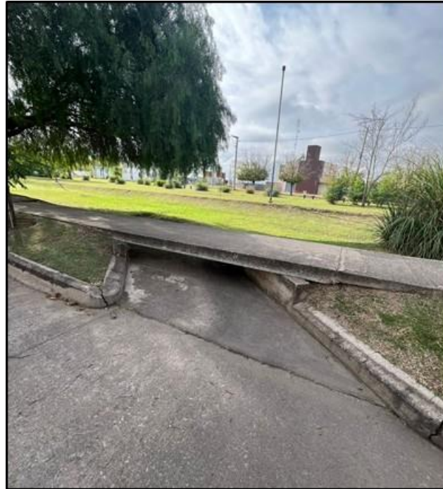
Figura 40 - Obra de ingreso 2 de laguna de retención 4
