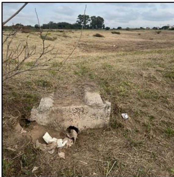
Figura 44 - Obra de egreso de laguna de retención 5
