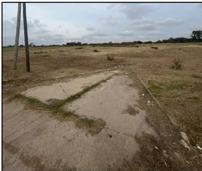
Figura 43 - Obra de ingreso de laguna de retención 5
