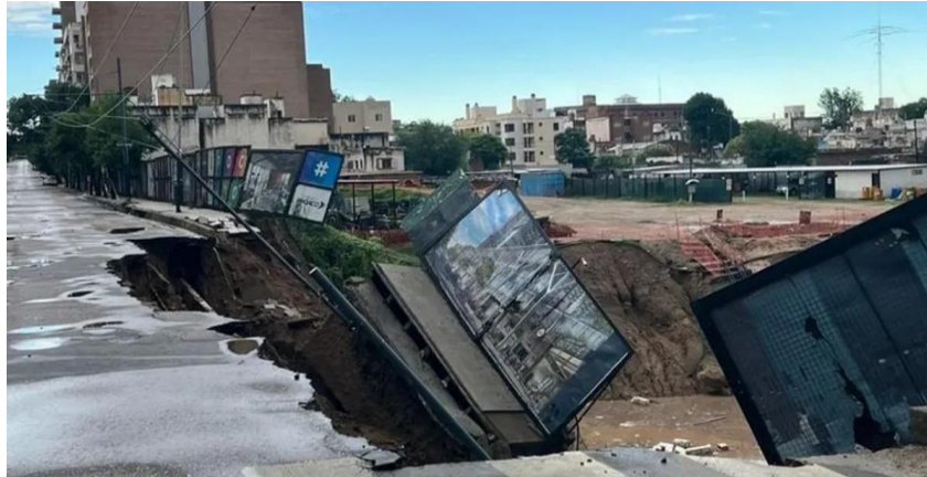
Figura 127 - Colapso del paquete estructural en calle V. Sarsfield, 01/01/2024
