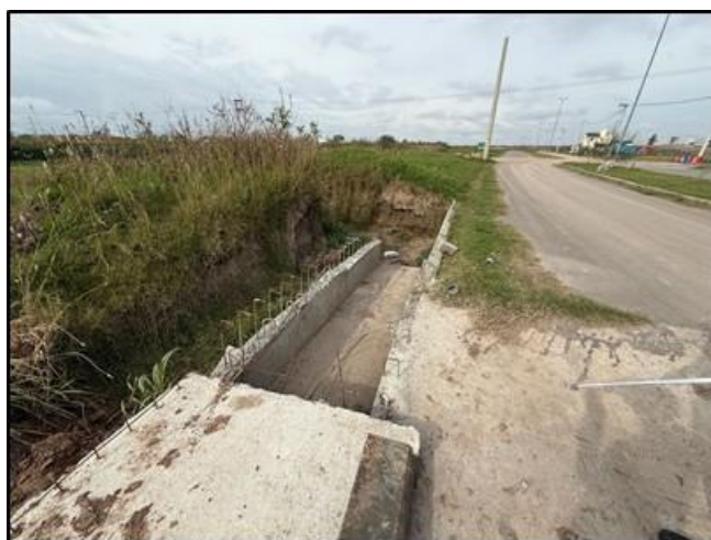
Figura 47 - Obra de ingreso de laguna de retención 6
