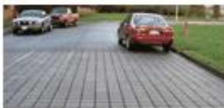
Figura 1.17 - Pavimento permeable
