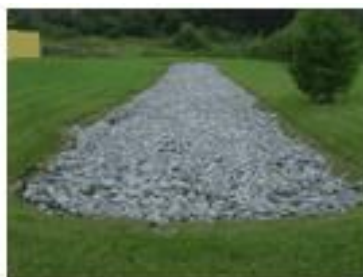
Figura 1.18 - Zanja de infiltración
