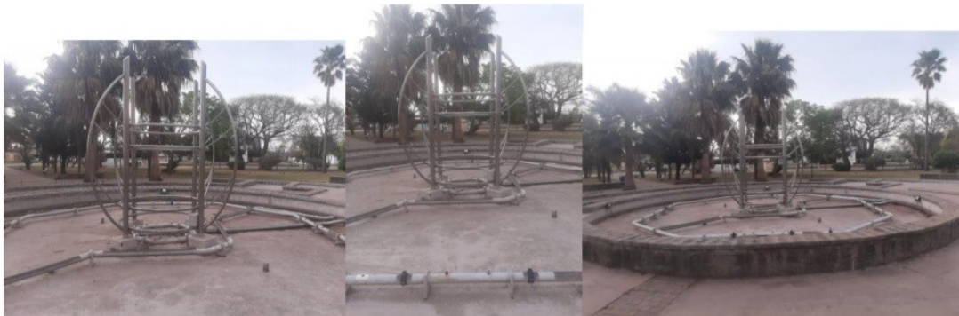
Imágenes Número 6, fotos de la fuente en mal estado:
