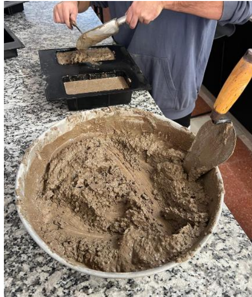
Ilustración 38: Llenado con mezcla que cumple con el Ensayo de Consistencia
