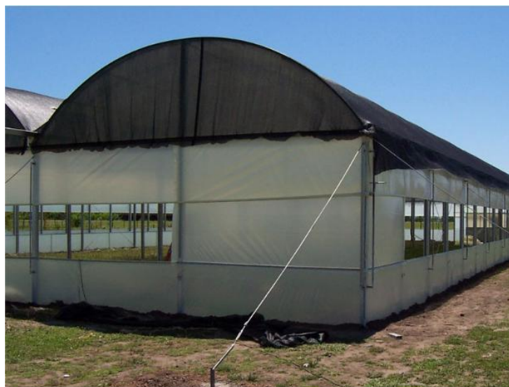
Figura 4: Estructura galvanizada (Invernaderos IRIE, 2025).
