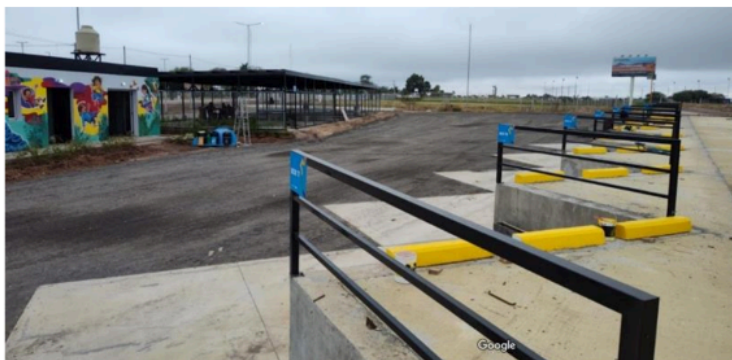
Ilustración 20 - Centro de transferencia Villa Unión
