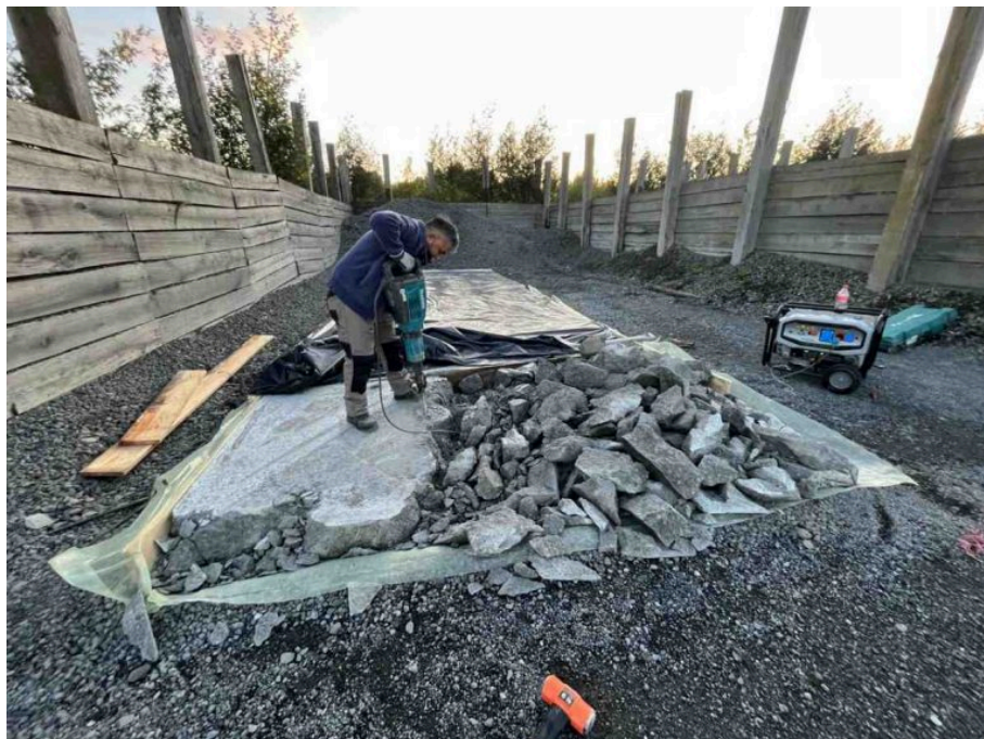
Ilustración 7 - Fragmentación de masa de hormigón endurecido
