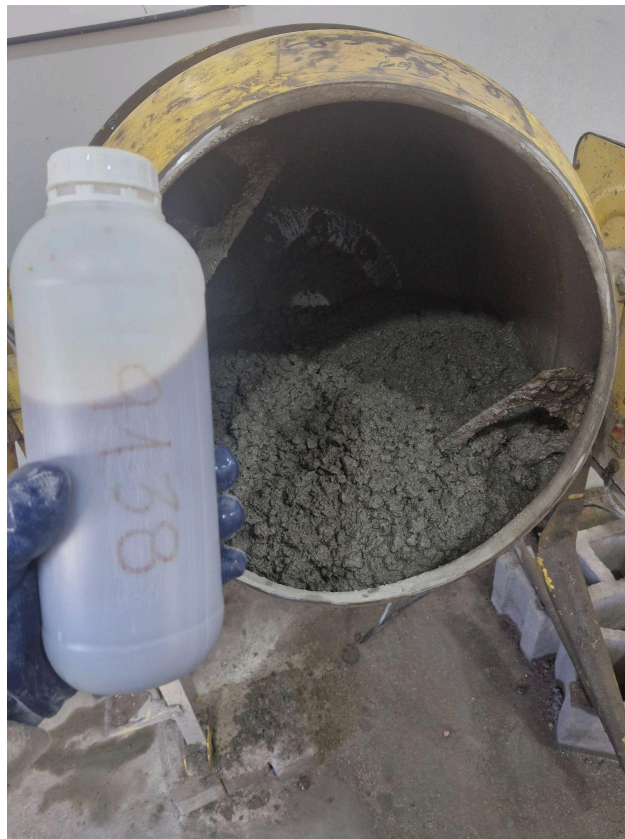
Ilustración 27 - Aditivo a punto de incorporarse en pastón de prueba
