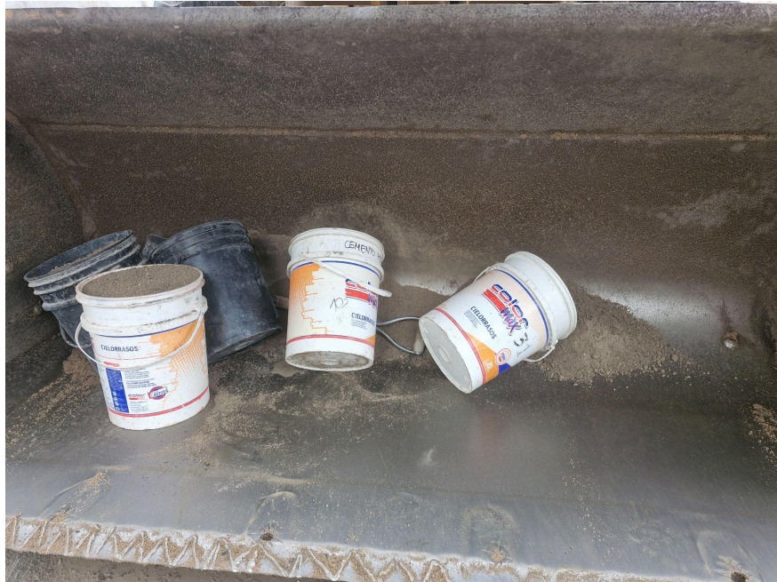
Ilustración 52 - Transporte de AR desde el acopio al cangilón
