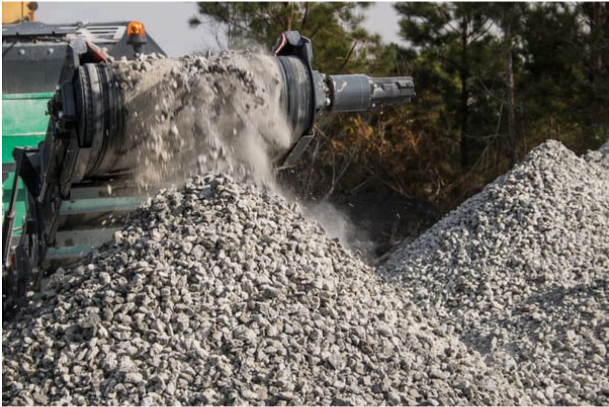
Ilustración 5 - Trituración de hormigón para la obtención de árido reciclado.
