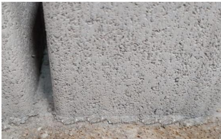
Ilustración 60 - Pata de elefante
