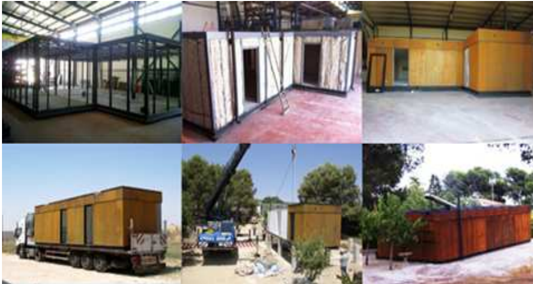
Figura 14: Construcción industrializada y modular. Fuente: www.construible.es/articulos/casa-menta
