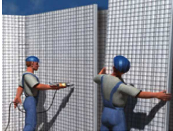
Figura 18: Instalación de paneles Cassaforma Fuente: www.cassaforma.com
