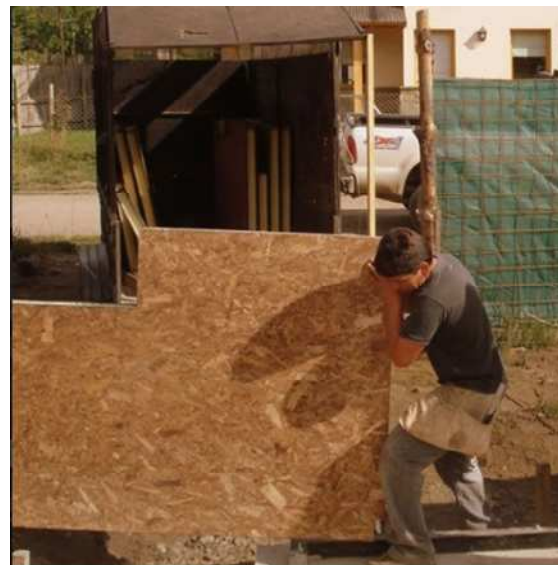
Figura 19. Montaje vivienda. Fuente: www.sipanel.com
