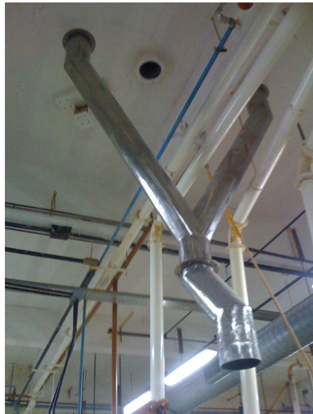
Figura 11: Propuesta de Y con 2 bocas de alimentación (Ahora).
